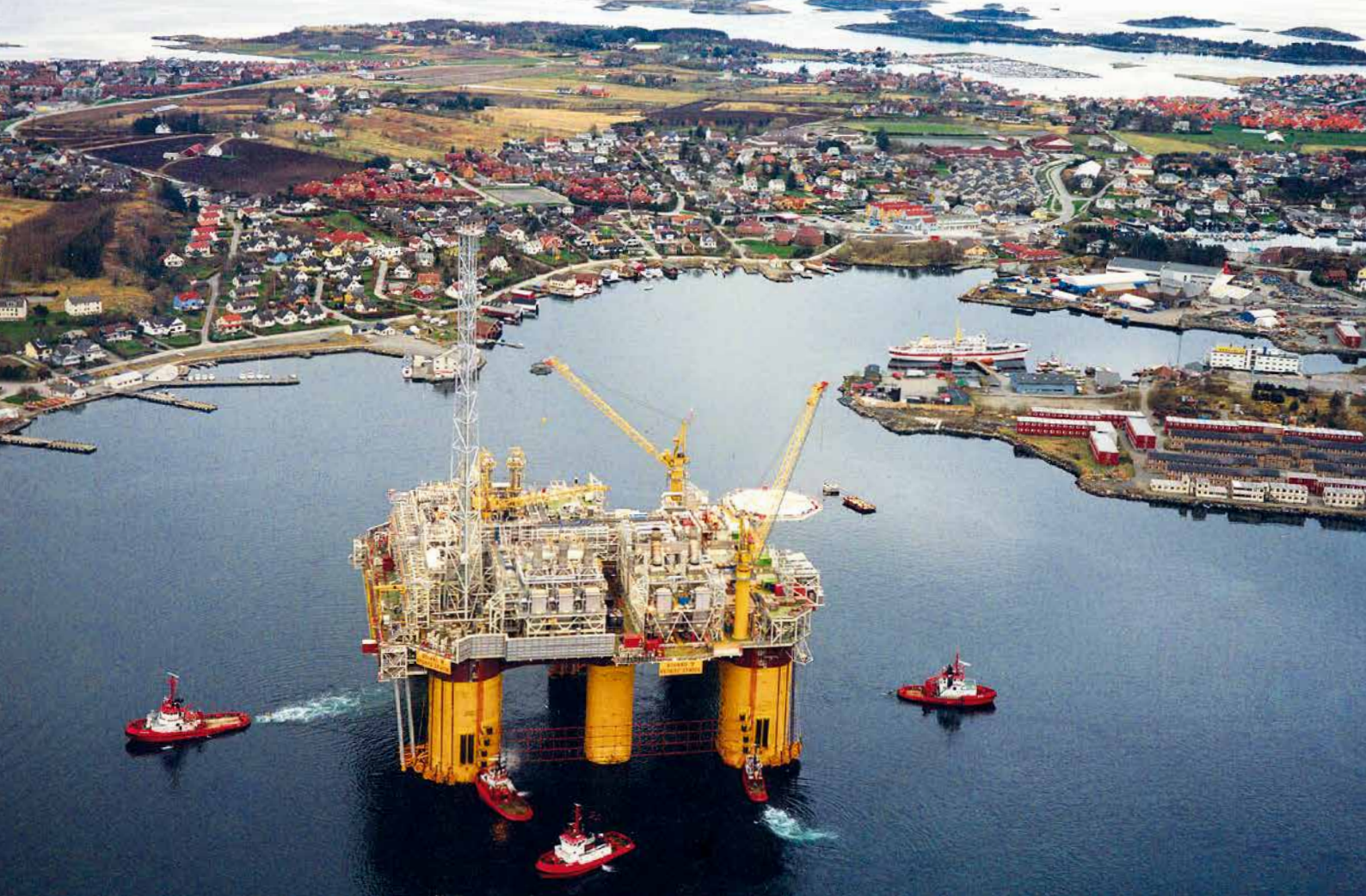
Ölplattform Asgard in Norwegen.
